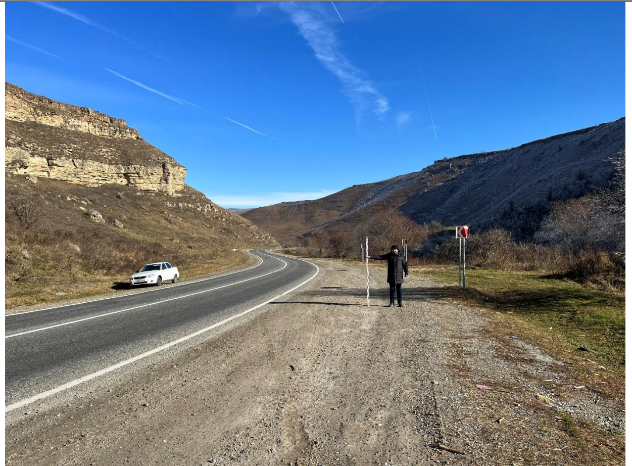
Рис. 16. Археологические исследования в зоне капитального ремонта автодороги А-156 км 0+000 – км 7+000. ТФ 6. Вид на ВСВ
