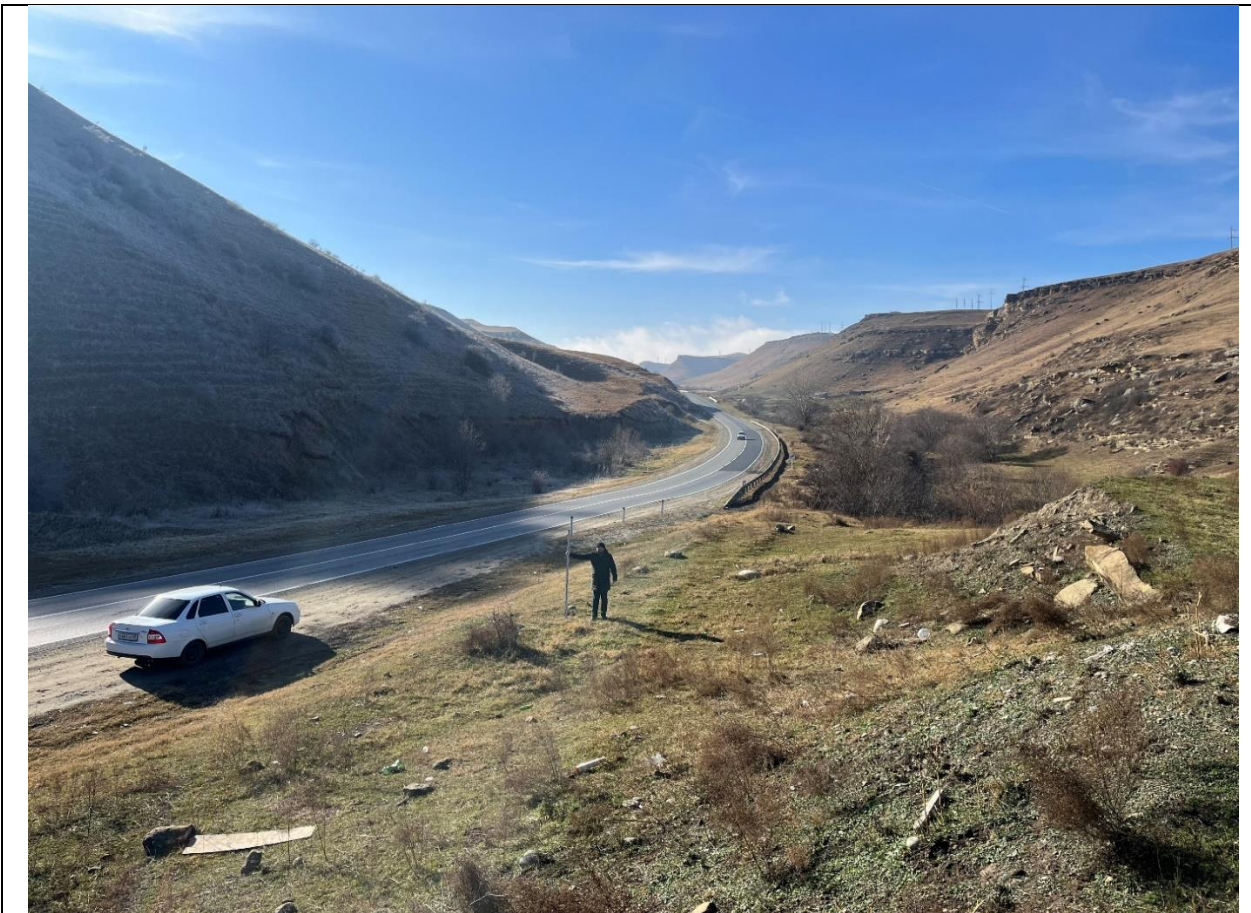
Рис. 11. Археологические исследования в зоне капитального ремонта автодороги А-156 км 0+000 – км 7+000. ТФ 3. Вид на ЮЗ
